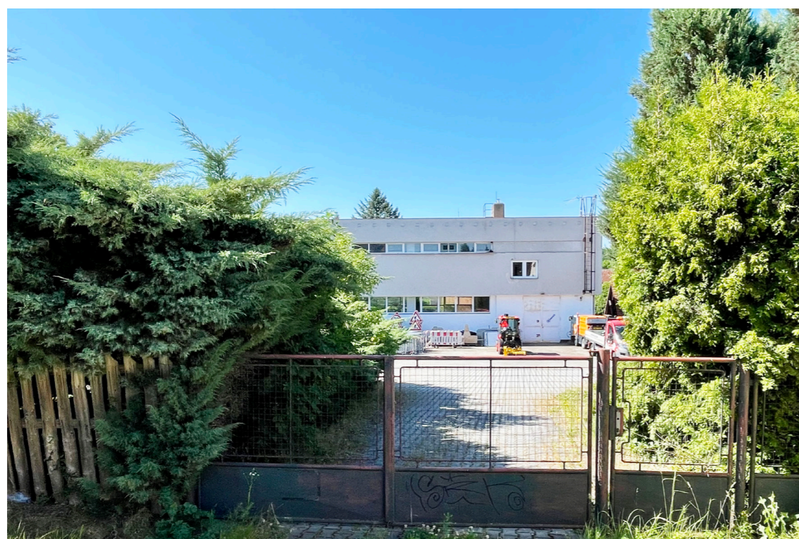
ŠPATNÝ STAV TECHNICKÉHO DVORU
