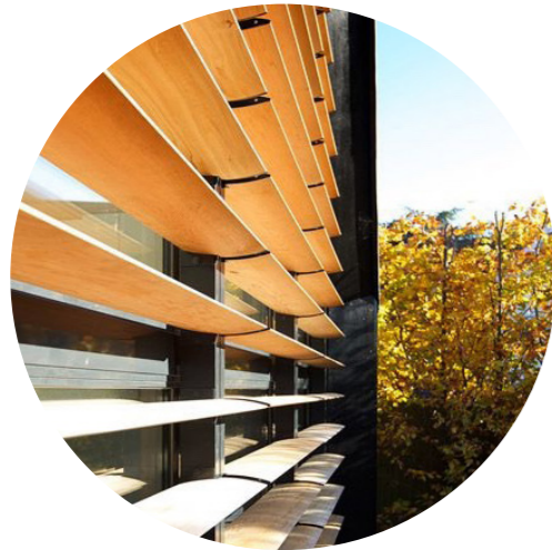
HORIZONTÁLNÍ LAMELY DŘEVĚNÉ - případně plech, design dřevo
