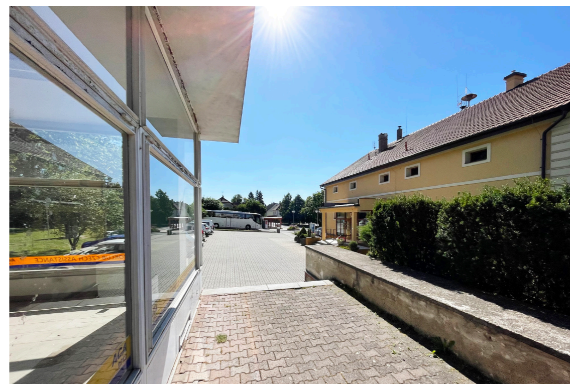
NEVHODNÉ VÝŠKOVÉ BARIÉRY
